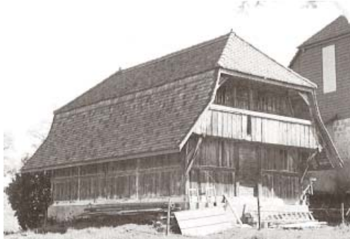
exemple de bâtiment de note 2 (grenier sur cave, Chevroux)
