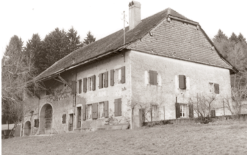
Valeur architecturale, équilibre de la composition. Bâtiment de note 2, à Cheseaux-Noréaz.
