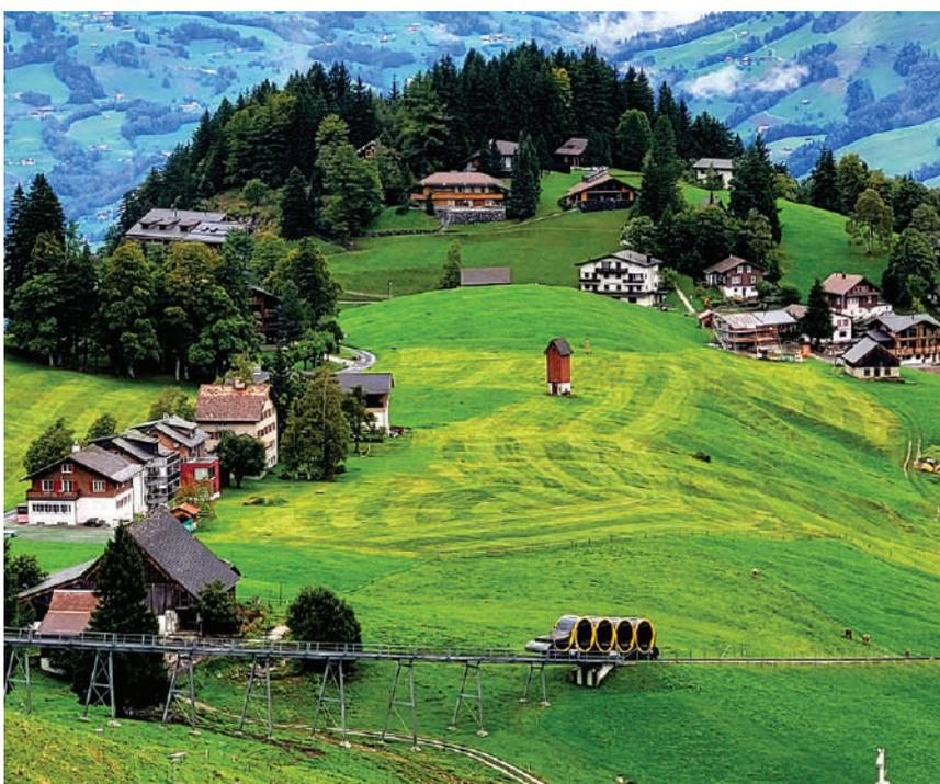
passagers par heure, à une vitesse de 10 mètres par seconde, soit 36 km/h, il ne lui faut pas plus de sept minutes pour franchir les 1740 mètres de dénivelé de l'ascension.
