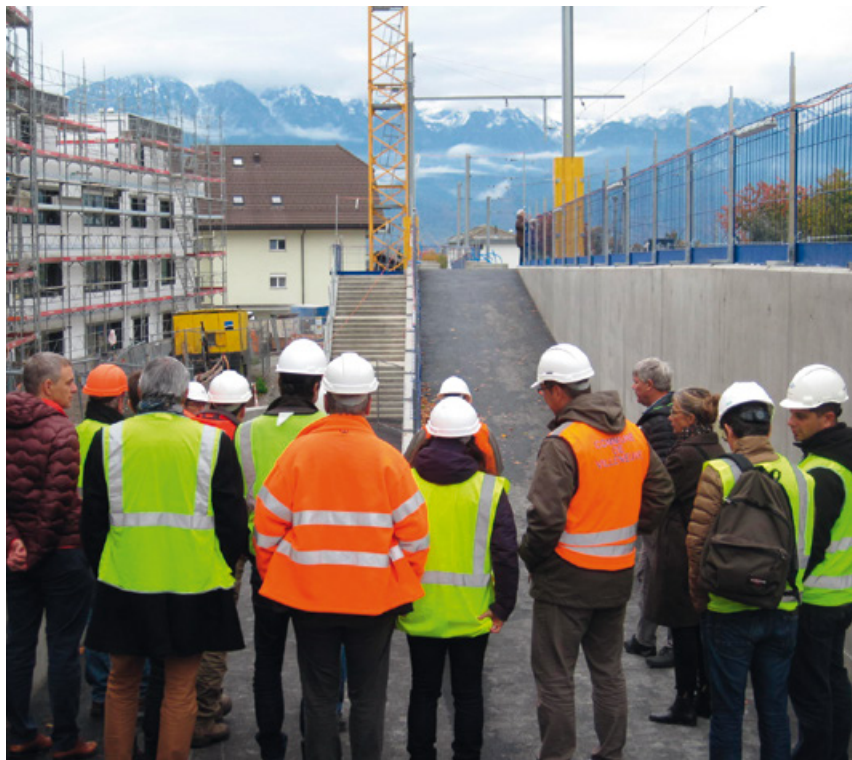
Visite du quartier Grandchamp à Saint-Légier-La Chiésaz, chantier complexe de par sa taille et sa proximité avec un autre chantier d'envergure à la gare. Les membres de l'AVIATCO présents ont pu poser toutes leurs questions et comparer ce projet avec ceux en cours dans leur service.
