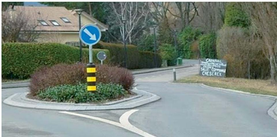
Le bon exemple: Les bordures abaissées de ce rond-point permettent l'empiètement des pneumatiques sans dommage
